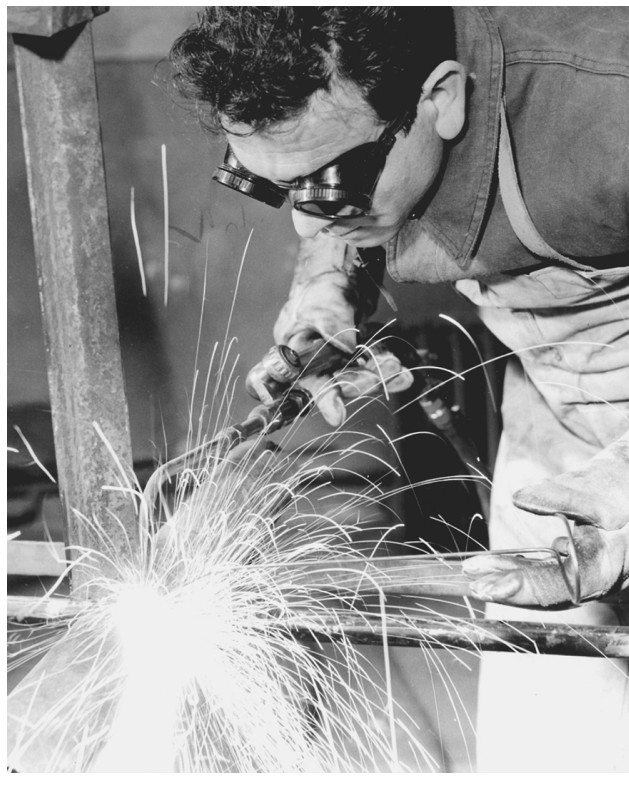
Figura 82.2 • Soldadura y corte con gas con soplete y varilla de metal de aportación. El soldador está protegido por un mandil de cuero, manoplas y gafas de seguridad.
