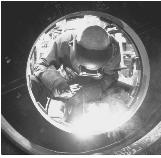
Figura 82.3 • Soldadura en un espacio cerrado.
