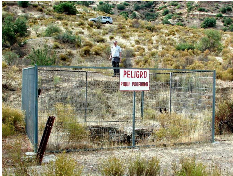
Fotos 2a (izquierda) y 2b (derecha), mostrando un pozo con embocadura colapsada (2a) y con señalización y protección para evitar riesgo de caídas. Pique es pozo en Chile.
