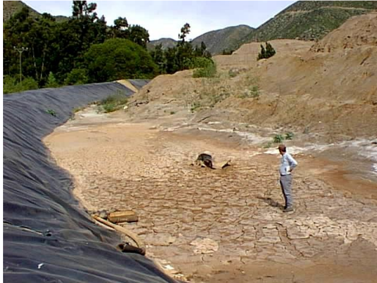
Foto 5.- Impermeabilizado basal de escombrera. Punitaqui (Chile).
