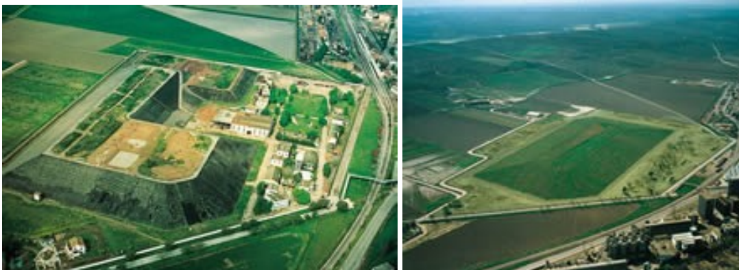
Fotos 6a (izquierda) y 6b (derecha), mostrando el aspecto final del complejo de la fábrica de uranio de Andujar (Jaén, España) tras el cese de sus actividades (6a), y tras el aislamiento completo del complejo (6b).
