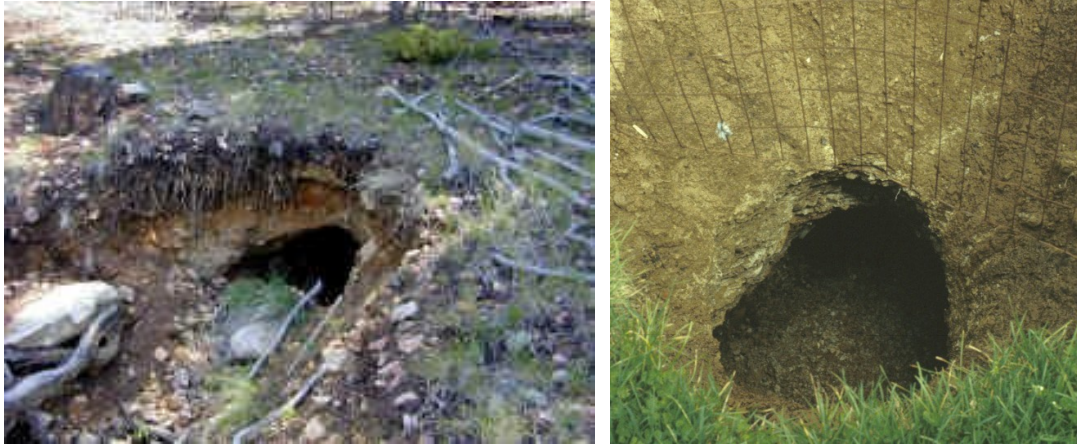
Fotos 3a (izquierda) y 3b (derecha), que muestran una embocadura de galería colapsada, y un pozo formado por colapso de una galería de escasa profundidad. Pulse sobre cada una de las imágenes para ver como se forman
